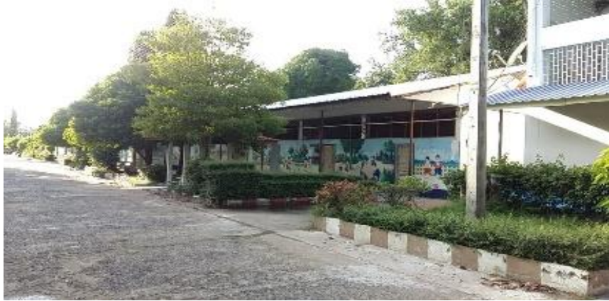
อาคารเรียน สปช.๑๐๒/๒๖ สร้างปี พ.ศ. ๒๕๒๗
