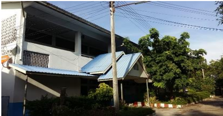
อาคารเรียน สปช.๑๐๕/๒๙ สร้างปี พ.ศ. ๒๕๓๙
