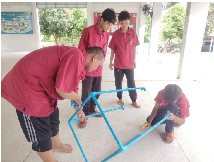
การนำท่อ PVC มาขึ้นโครงถังขยะที่ออกแบบไว้
